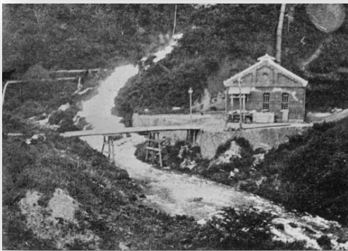
かつての沼上発電所
